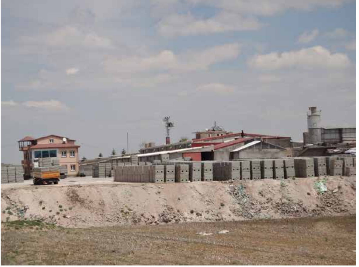
Şekil 2.19 Bimsblok üreten tesislerden tipik bir görünüm
